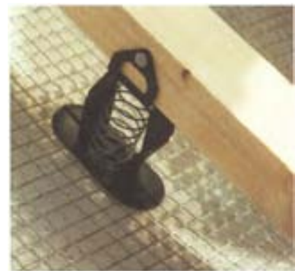
Figur 5. Fjeder til fastholdelse af undertag mod lægter.
